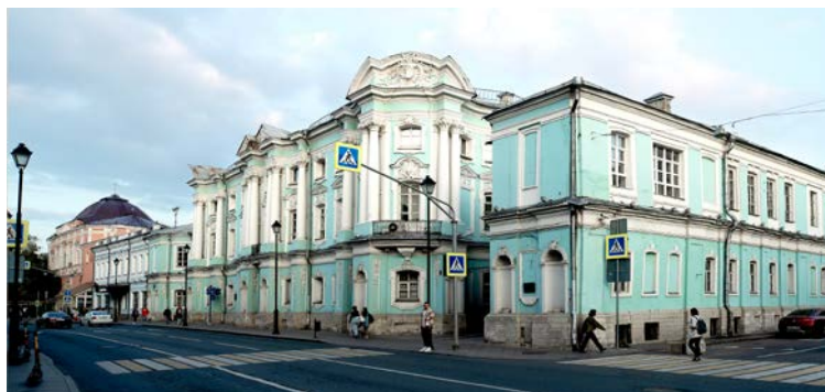
ЗДАНИЕ МОСКОВСКОЙ 4-Й МУЖСКОЙ ГИМНАЗИИ - ДОМ АПРАКСИНЫХ- ТРУБЕЦКИХ. МОСКВА, УЛ. ПОКРОВКА, 22. НАШИ ДНИ
